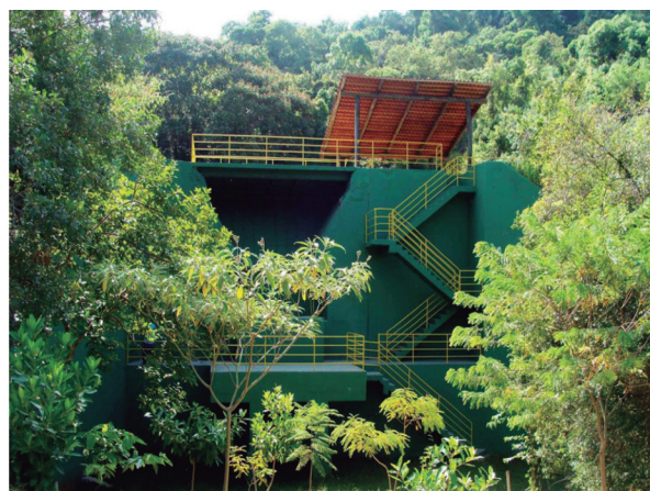
Figura 10 - Mirante construído usando a base da britagem primária em julho de 2017.
