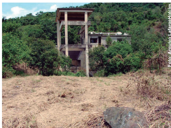
Figura 9 - Estrutura da britagem primária em setembro de 2008.
