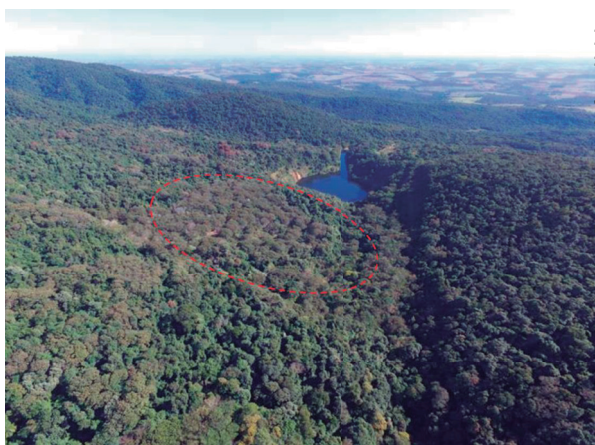
Figura 6 - Minas Felicíssimo Sul (contorno pontilhado) e Felicíssimo Norte (lagoa ao fundo) em julho de 2017.
